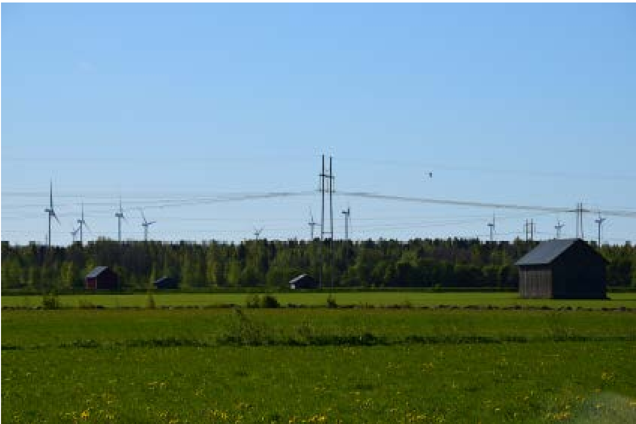
Bild 5. Kraftledning och vindkraftverk vid Torkkola vindkraftsområde i Vasa (Christine Bonn, 2016)
